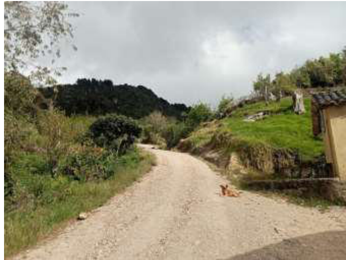
Estado de la Vía Vereda Tejar Arriba Fecha de Registro 23 de octubre de 2024
